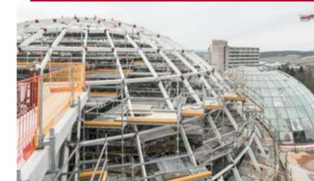
Segmentweiser Aufbau der Stahlträger
